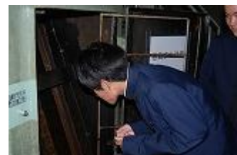
下水処理場施設見学
