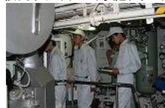
えひめ丸体験航海実習 （機関室）
