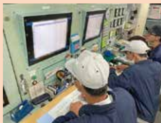
機関当直(運転状態の記録)
