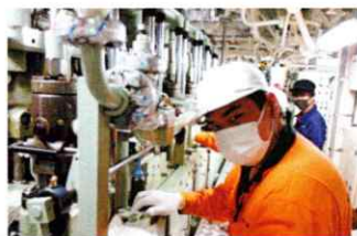
主機点検整備
