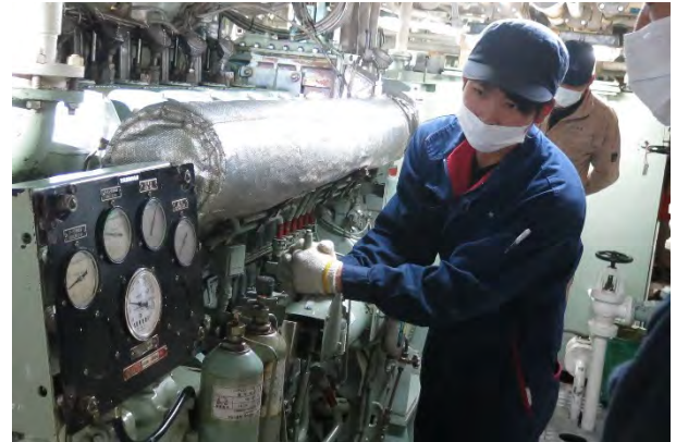
機関当直（発電機起動）
