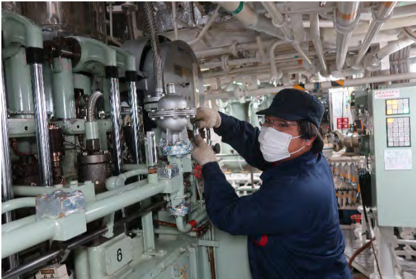
機関当直（主機起動）
