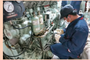
当直業務(発電機状態確認)
