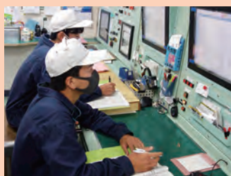
機関当直(運転状態の記録)
